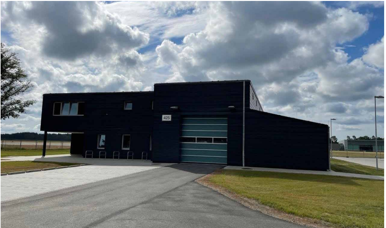
Neues Funktionsgebäude inklusive Kraftstoffbeprobungslabor und Wartungsgrube.
